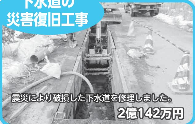
震災により破損した下水道を修理しました。
