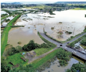
河川の氾濫により甚大な被害を受けた川内地区
