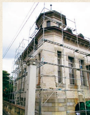
修復作業中の「洋館」
