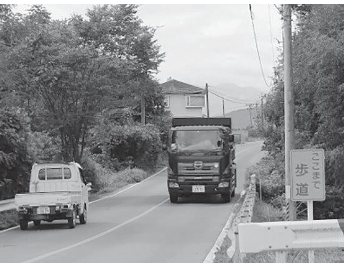
歩道の未整備区間がある県道五十沢国見線
