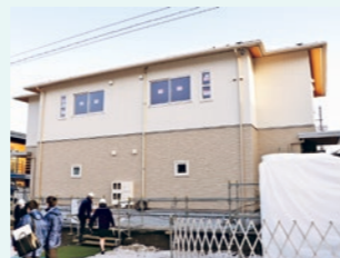
建設中の板橋南子育て住宅
