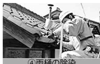
④雨樋の除染
