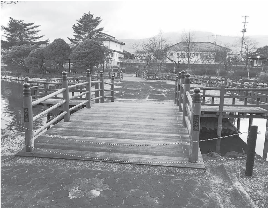
現在供用を停止している観月台公園内の橋
