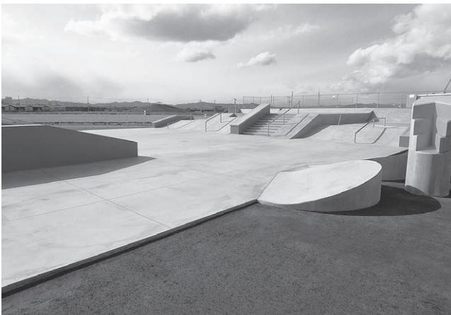
宮城県亘理町にあるスケート ボード施設
