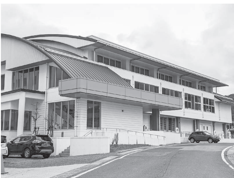
築10年程度と比較的新しい国見小体育館
