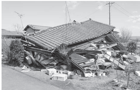
東日本大震災では、耐震性能を有さない家屋の多くが甚大な被害を受けた
