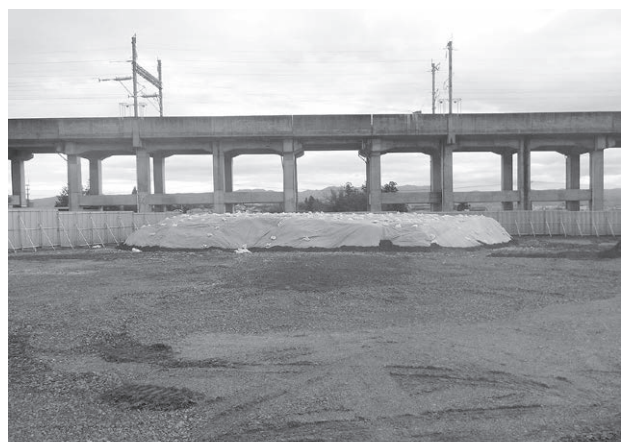
資材置場となっている山崎字前柳地内の土地
