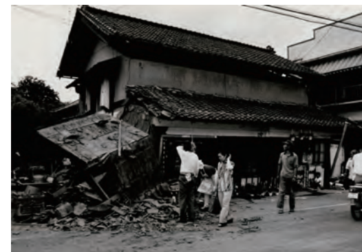
宮城県沖地震で倒壊した家屋
