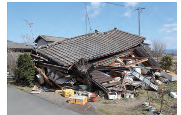
東日本大震災で倒壊した家屋
